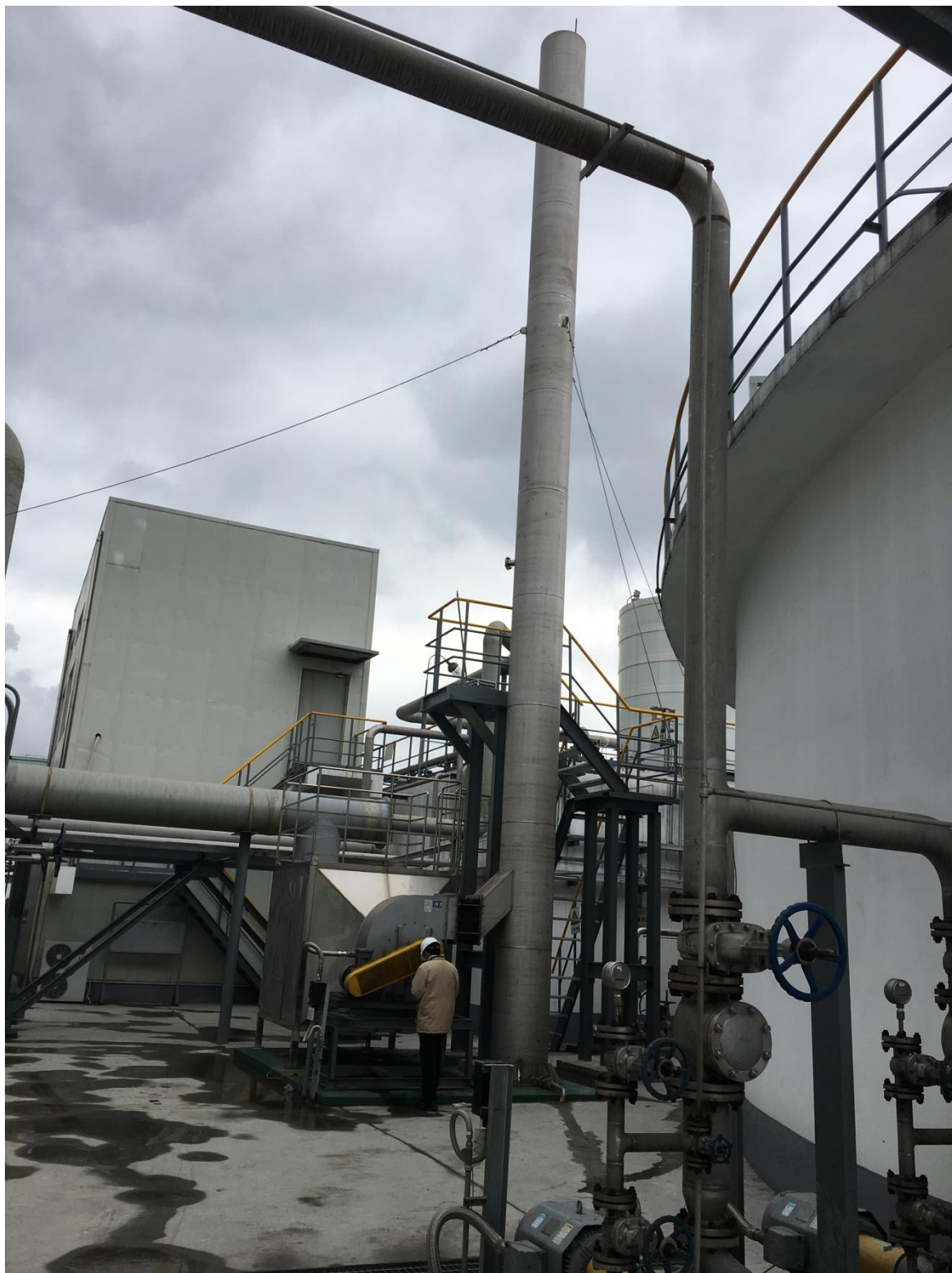
图 1 4#WWT 污水处理系统活性炭装置排气筒
