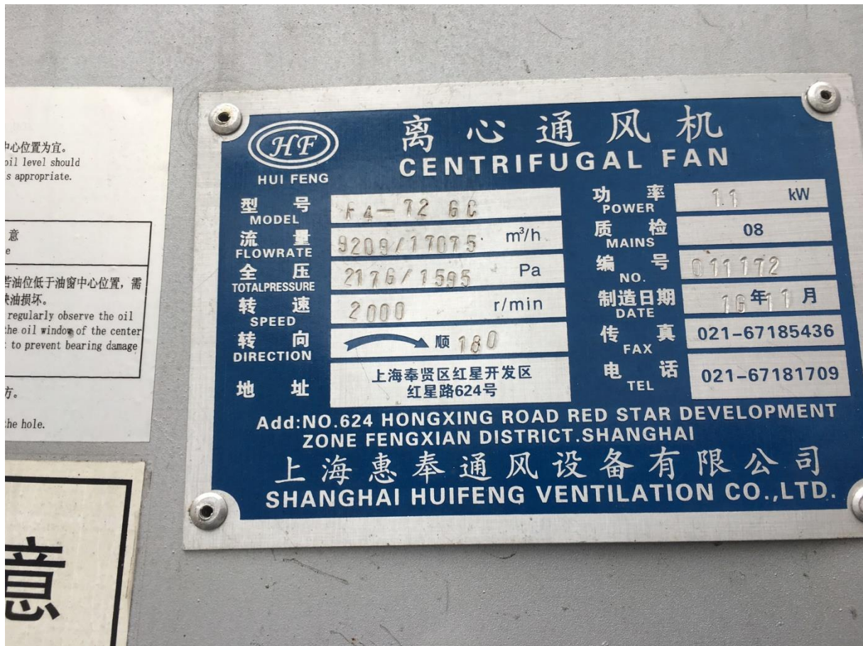
图 2 4#WWT 污水处理系统活性炭装置风机铭牌
